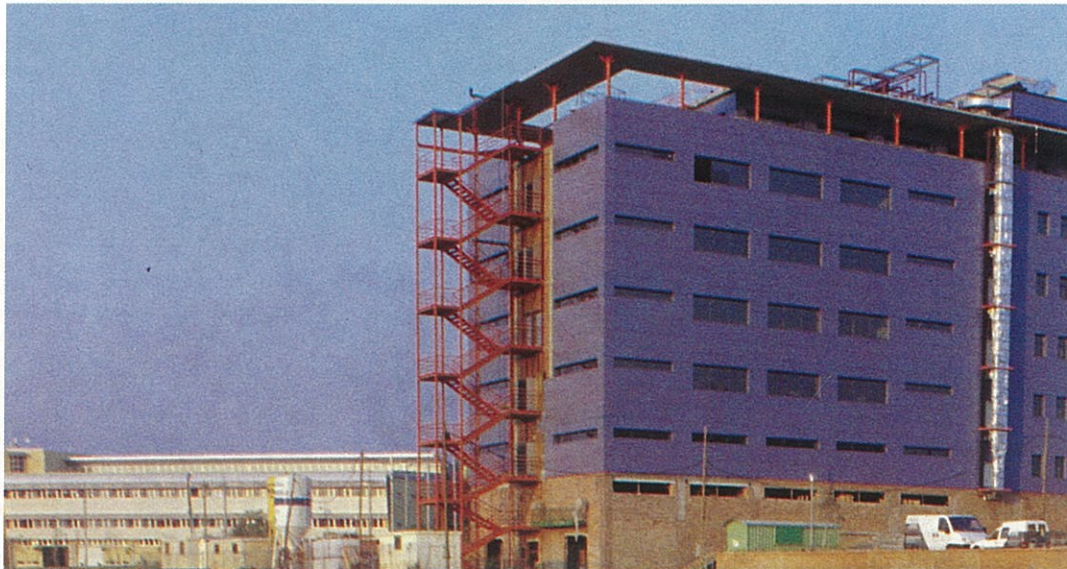
El edificio que albergará los laboratorios universitarios estará terminado en 1995
