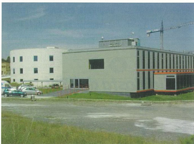
► Vista del edificio
