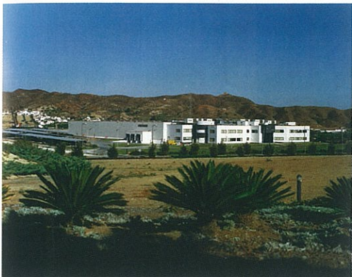
ALCATEL Parque Tecnológico de Andalucía-Málaga
