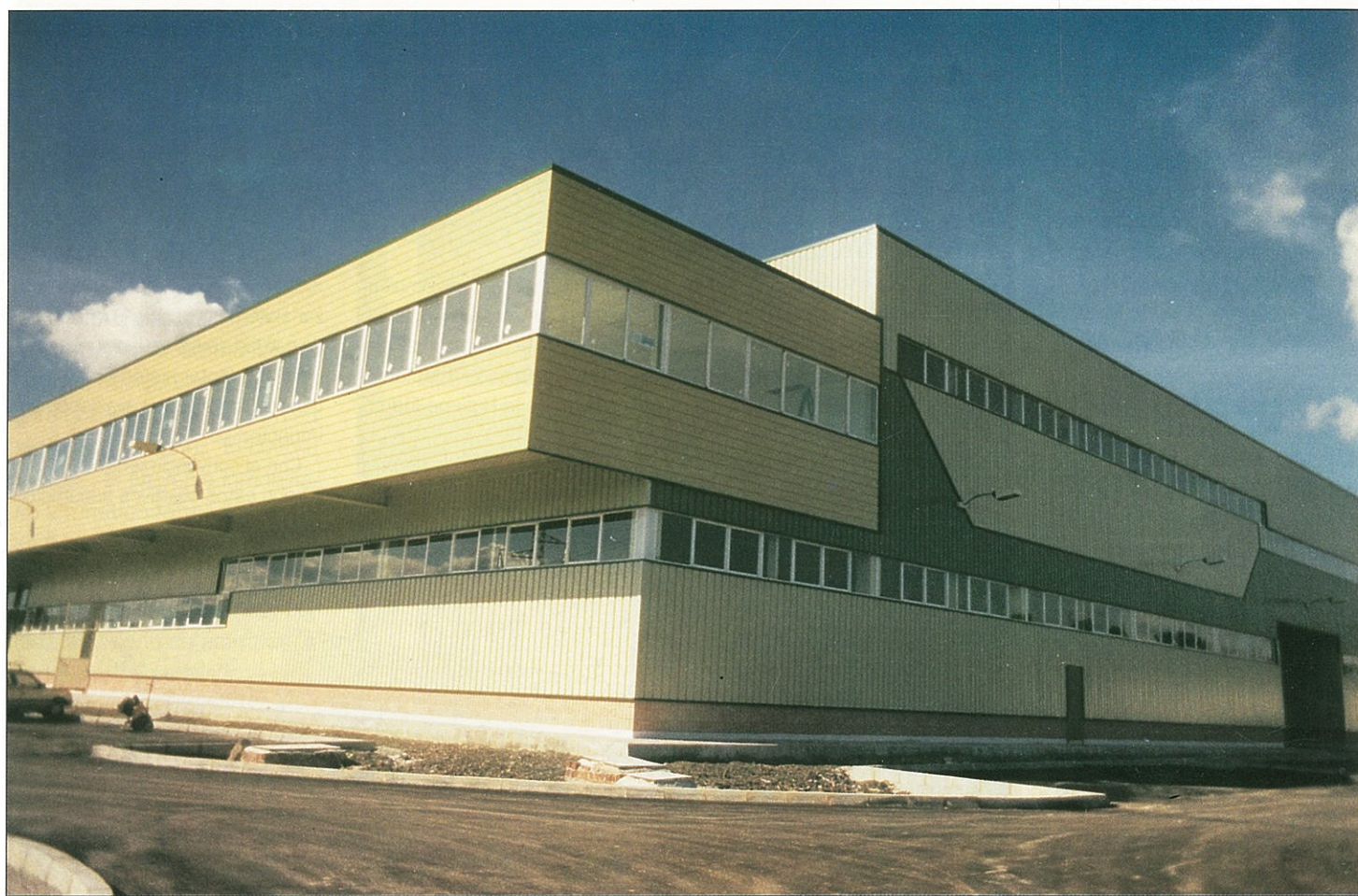
Vista general de edificio.
