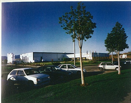
AIR LIQUIDE SEO Parque Tecnológico de Andalucía-Málaga
