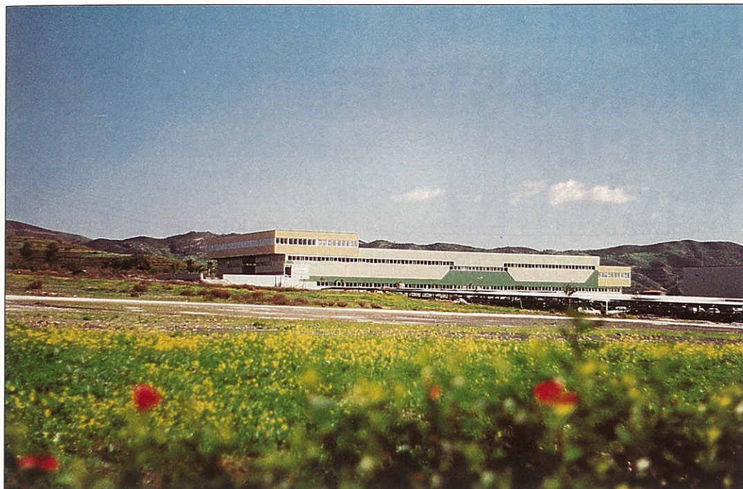
El edificio está construido en dos alturas.
