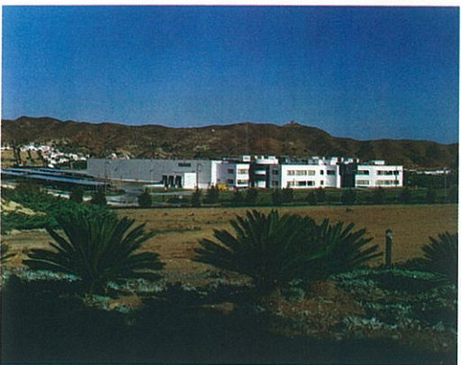
ALCATEL Parque Tecnológico de Andalucía- Málaga
