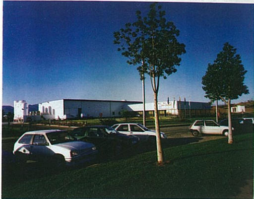
AIR LIQUIDE SEO Parque Tecnológico de Andalucía-Málaga
