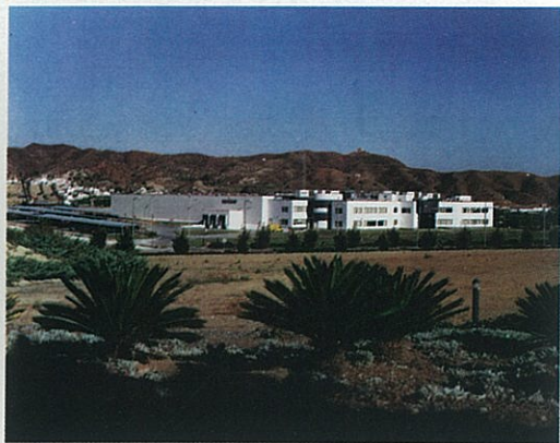
ALCATEL Parque Tecnológico de Andalucía-Málaga
