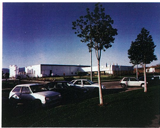
AIR LIQUIDE SEO Parque Tecnológico de Andalucía-Málaga
